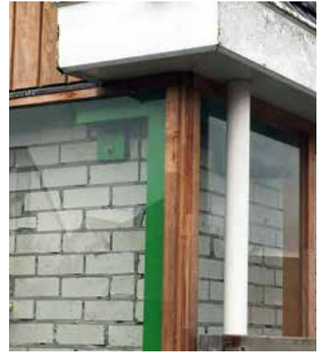
Door schade getroffen woning in Loppersum, opgekocht door NAM, waarbij versterkingsmaatregelen ter demonstratie in het zicht zijn gelaten.
