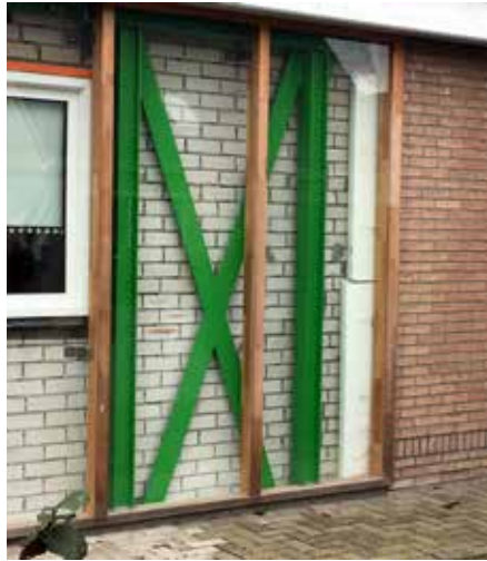
Door schade getroffen woning in Loppersum, opgekocht door NAM, waarbij versterkingsmaatregelen ter demonstratie in het zicht zijn gelaten.
