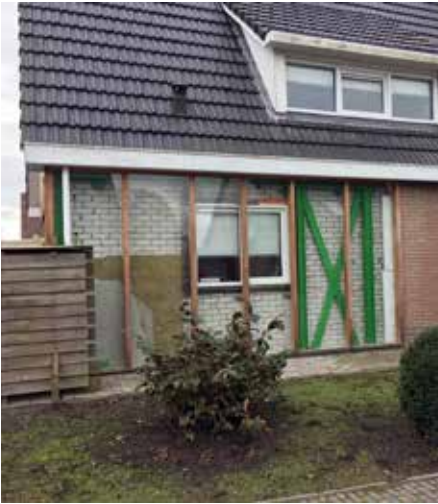
Door schade getroffen woning in Loppersum, opgekocht door NAM, waarbij versterkingsmaatregelen ter demonstratie in het zicht zijn gelaten.
